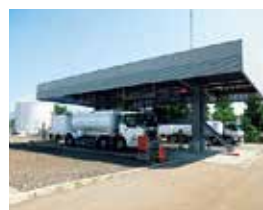
能登空港給油施設
